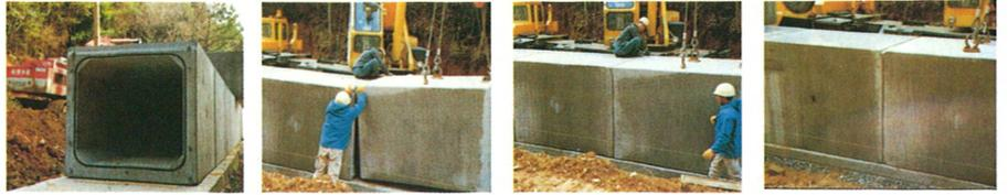
第1図は既に設置された製品①～⑥に対して、製品⑦を設置しかけている状態である。下の詳細図のように⑦を傾斜させて、まず⑥の上部テーパ面に固定されたガイドピンと⑦のテーパ穴を浅く接続する。次にクレーンを徐々に下げながら⑦を下方向にずらすと、⑦は自然と矢印方向に回転し、下部水平ガイドピンが接続される。クレーンのフームをごく小さく振ることによって上部、下部の4本のガイドピンはより奥まで貫入され、製品⑥と⑦は密着して設置される。第3図の製品の端部に設けた浅い溝(イ)に装着したシール材は、第2図のフラットな面(ニ)に密着するので、シーリングも完全に行われる。カップル・ガイド・ピン・ジョイント工法は以上のように製品同士の位置合わせ、引き寄せ密着を著しく簡単かつ確実に行うことができ、作業性の向上、工期短縮に大きく寄与する工法である。
